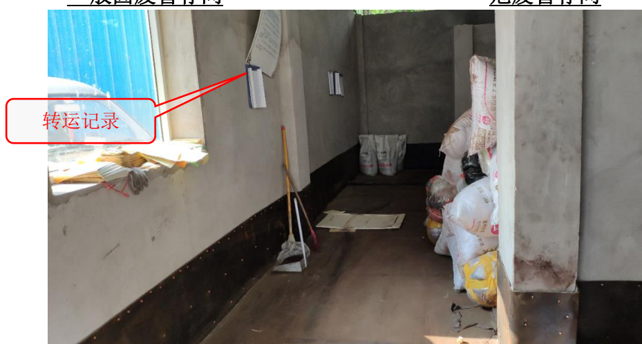
危废暂存间内部
