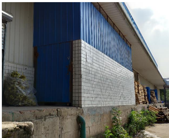
一般固废暂存间
